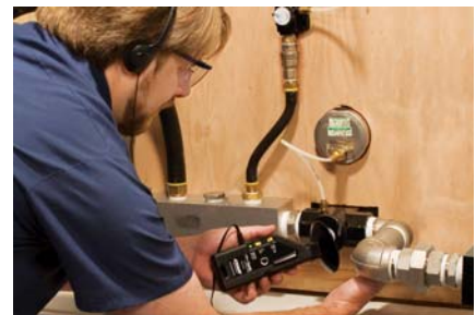
Verifica presenza perdite da raccordi pneumatici
