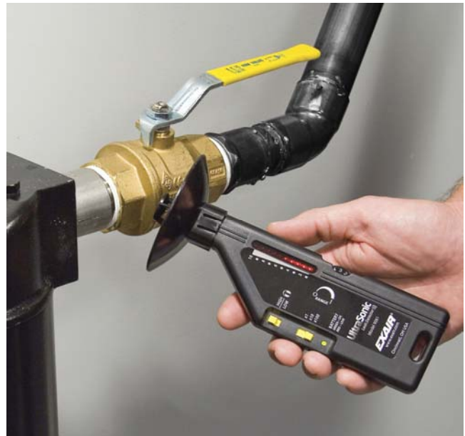
Verifica perdite da raccordi pneumatici
